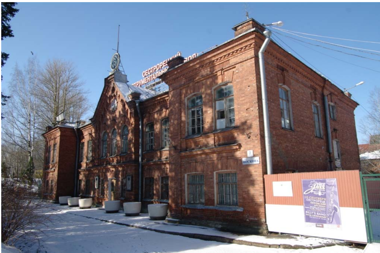
Здание Заводоуправления. Фото 05.03.2017.
