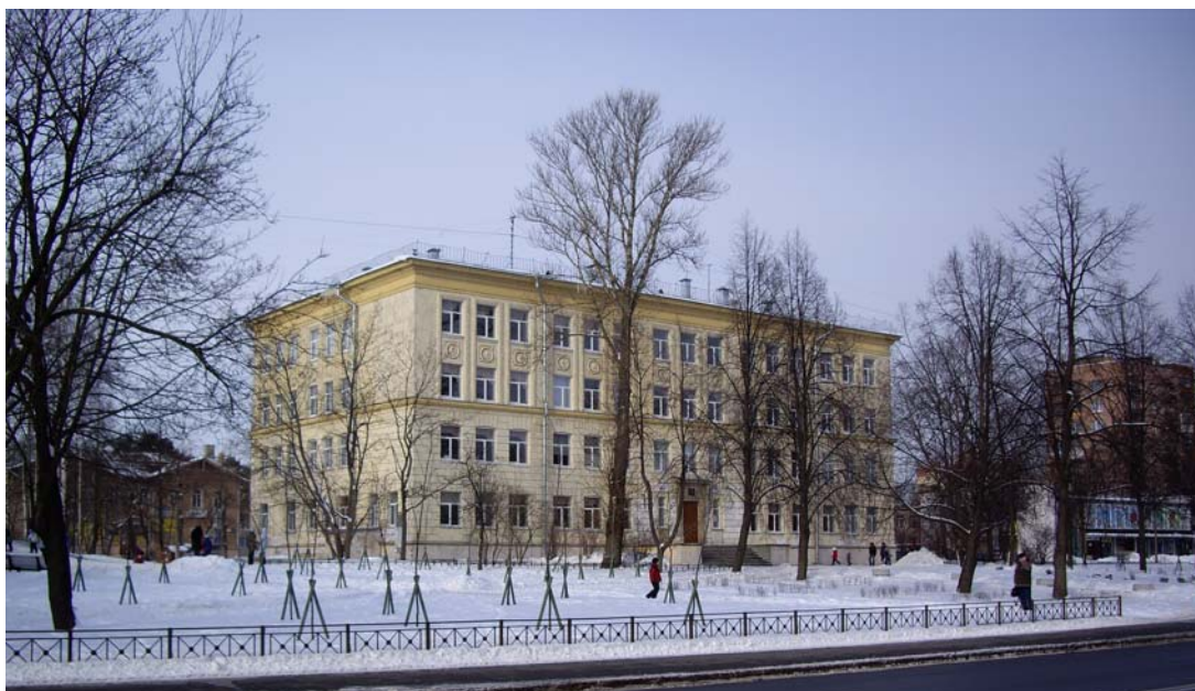
Здание школы № 541. Фото 14.12.2012.
