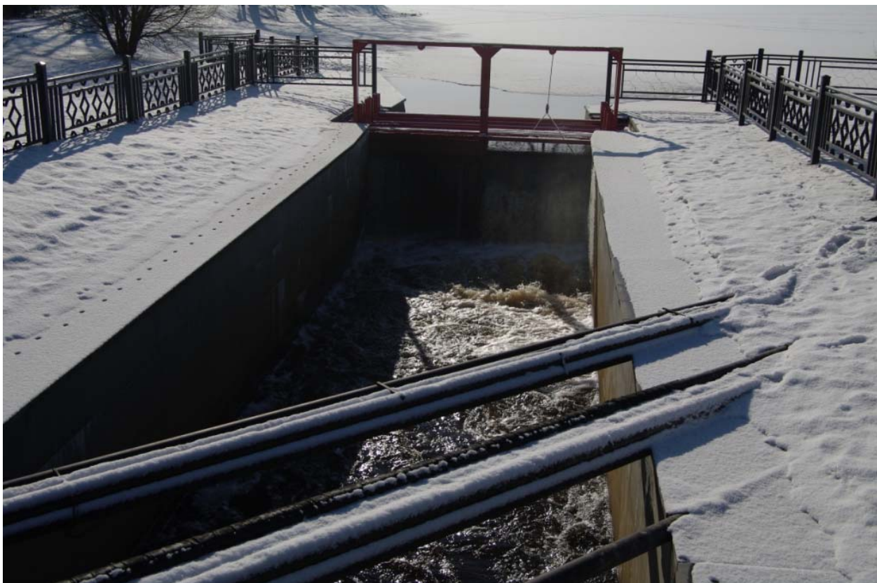
«Новый шлюз на Заводском бассейне». Фото 05.03.2017.
