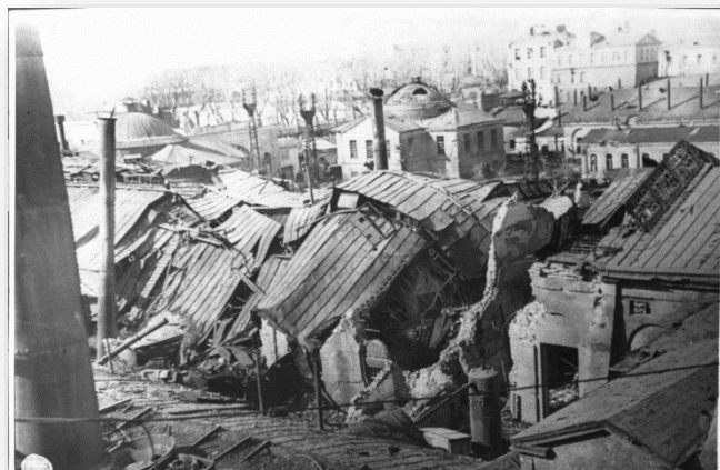
Разрушенный чугуно-литейный цех Ижорского завода, апрель 1943
