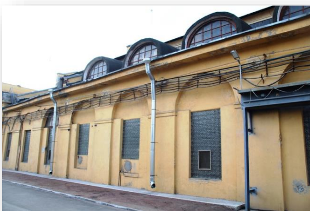
Фрагмент фасада сохранившихся плющильного, молотового заводов, медилитейной мастерской в настоящее время
