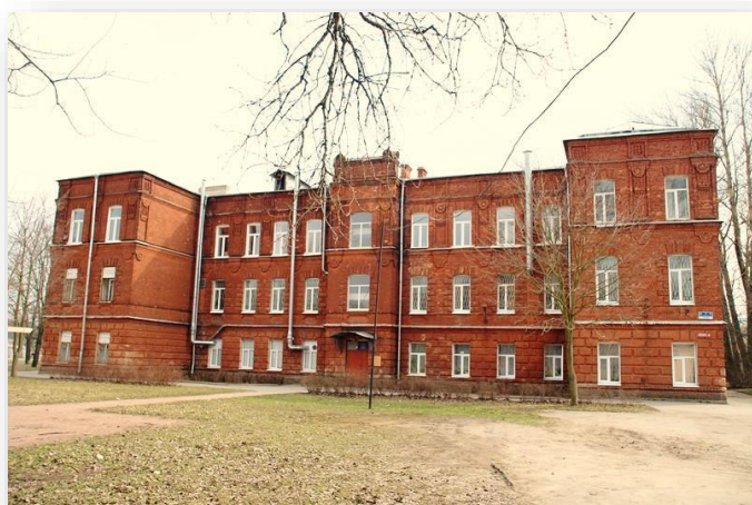
Здание бывшего жилого дома Адмиралтейских Ижорских заводов по Советскому бульвару, 7 в настоящее время
