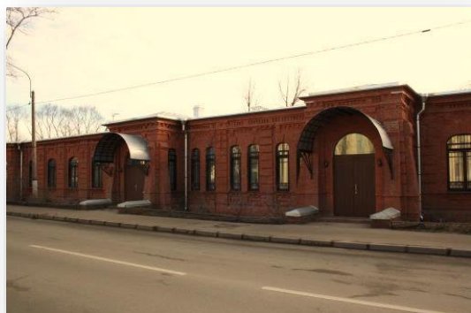
Здание бывшей заводской школы в настоящее время. Вид с улицы Володарского
