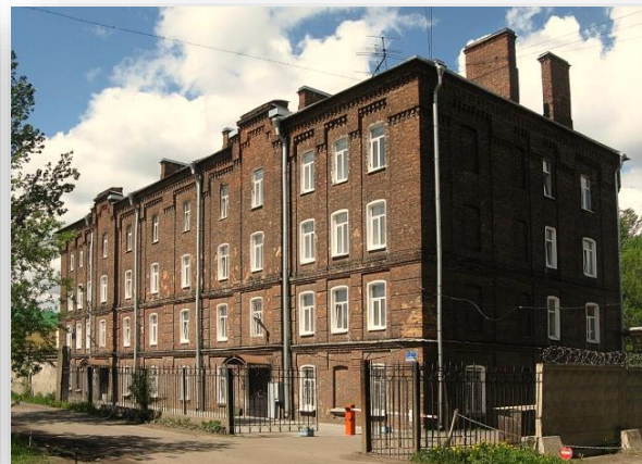
Здание бывшего жилого дома Адмиралтейских Ижорских заводов по Финляндской ул., 7 в настоящее время
