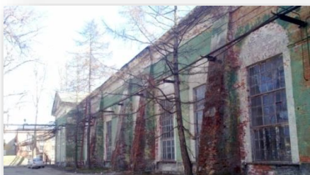
Фасады здания бывшей Новосборочной мастерской в настоящее время
