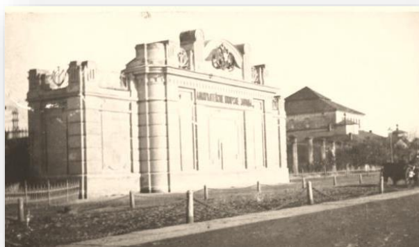
Стена на главной плотине. 1910-е
