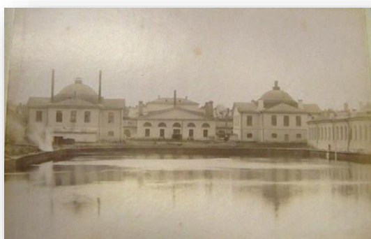
Газгольдер и сталелитейный корпус, начало XX в.
