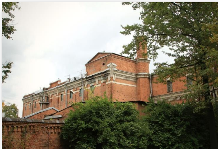
Дворовой фасад здания бани
