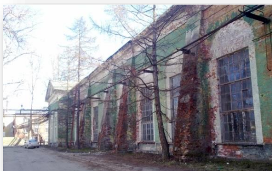
Фрагмент фасада бывшей новосборочной
