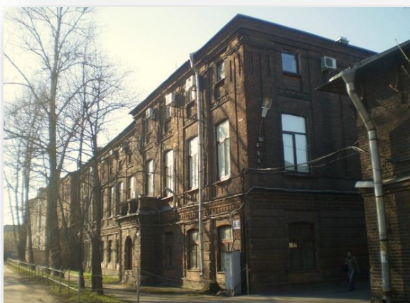
Здание бывшего жилого дома Адмиралтейских Ижорских заводов по Финляндской ул., 5 в настоящее время
