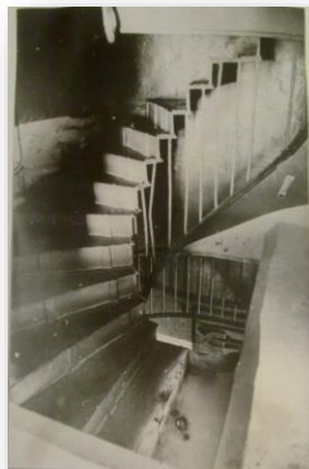
Сохранившаяся чугунная лестница
