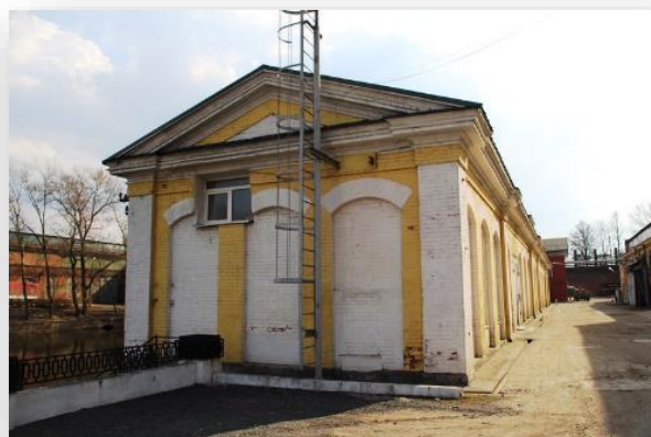
Торцевой фасад здания бывшей мастерской в настоящее время
