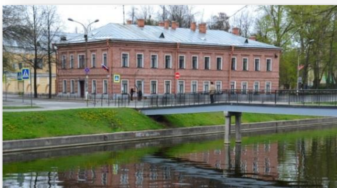
Фасад здания бывшего приюта со стороны Комсомольского канала в настоящее время
