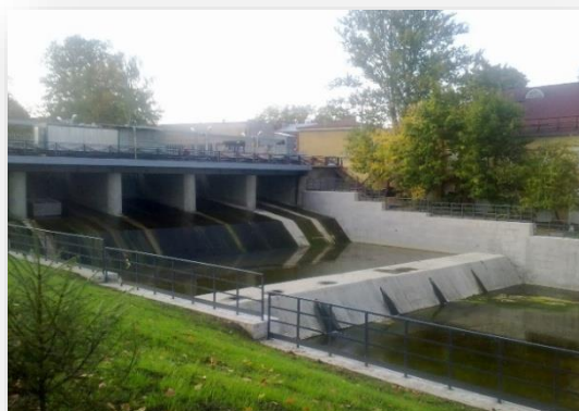
Вид на плотину № 2 со стороны территории Ижорского завода
