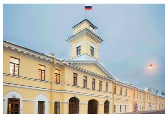
Здание Заводоуправления в настоящее время
