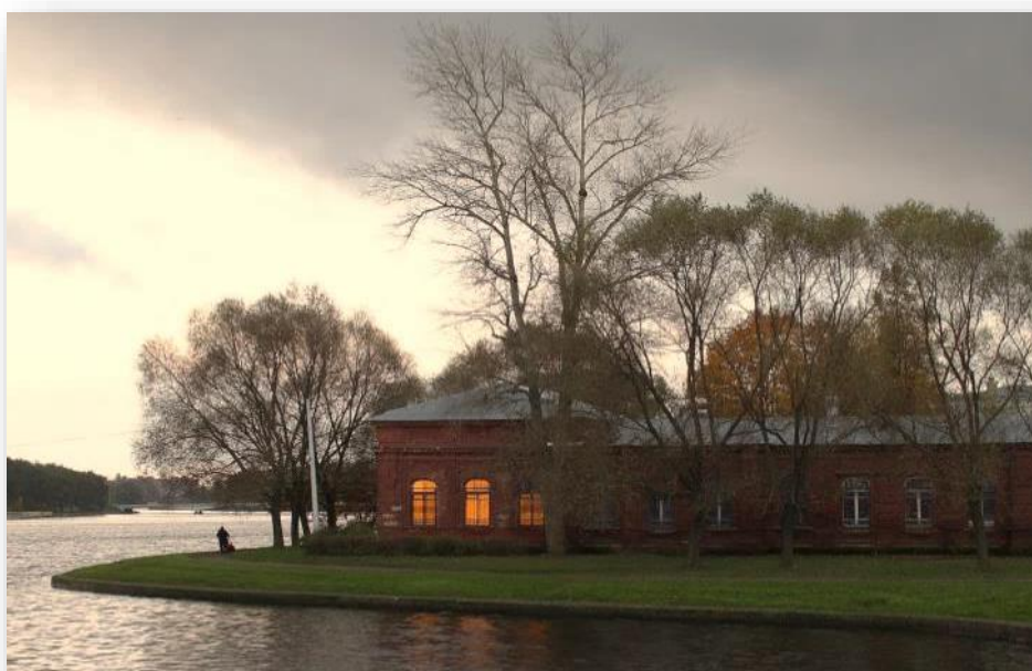
Здание бывшей заводской школы в настоящее время. Вид со стороны Адмиралтейского моста
